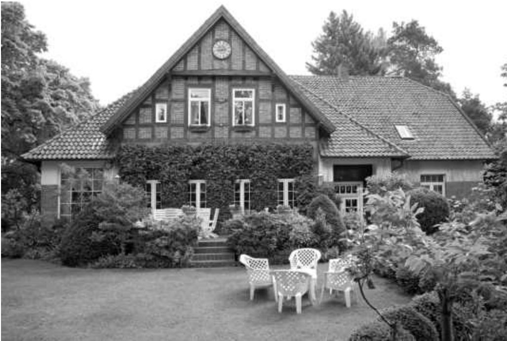
Das heutige Wohnhaus Am Mittelfeld 1
