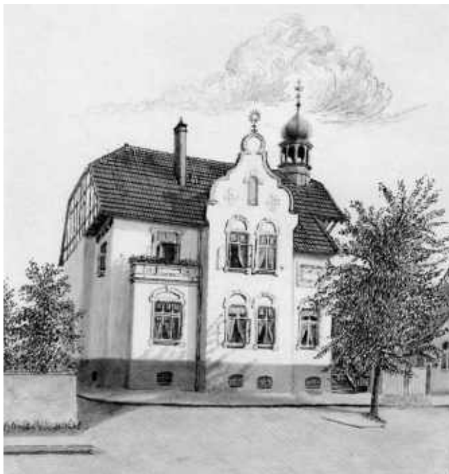
Heinrich Schuster hat dieses Bild seines Hauses Bahnhofstraße 16 im Jahre 1924 selbst gezeichnet.
